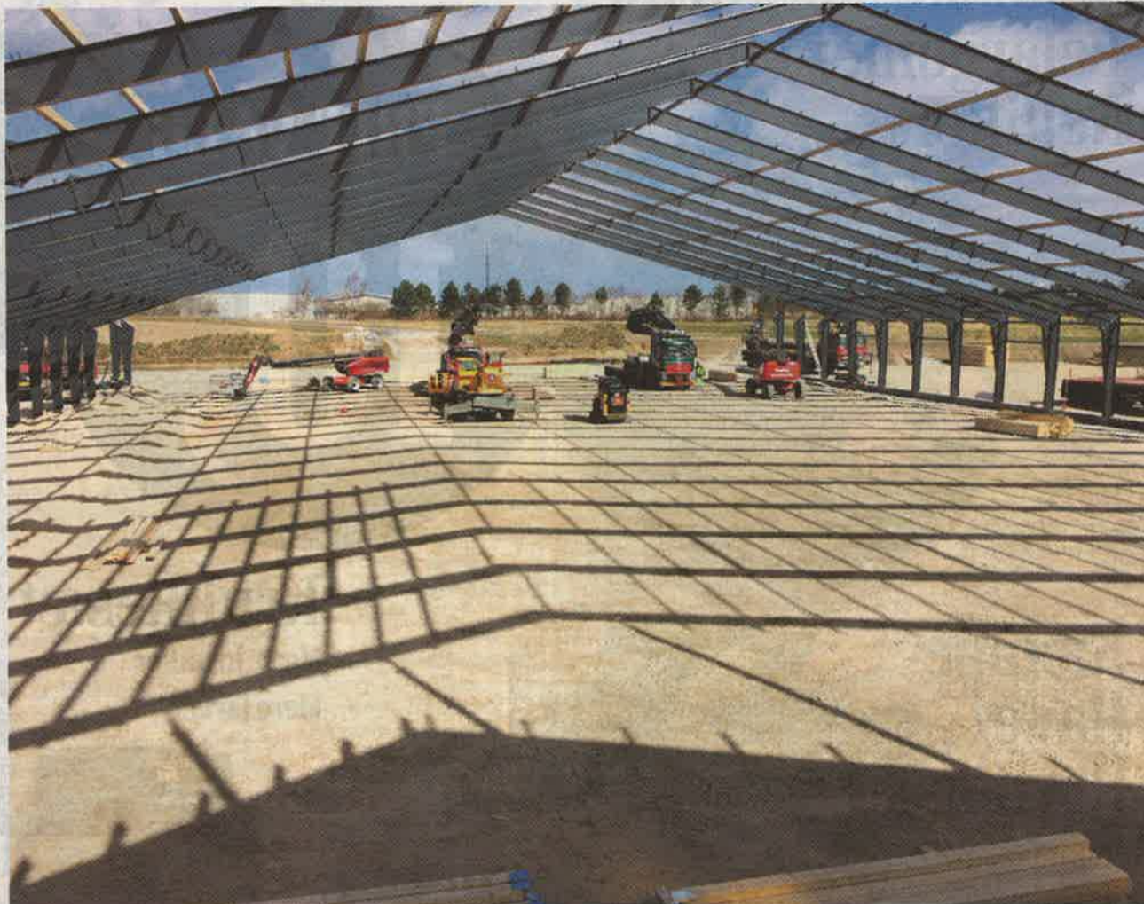
Disse enorme spær udgør rygraden i en ridehal på 4000 kvadratmeter i nærheden af Lejre. Maskinerne midt i hallen giver et indtryk af, hvor stor hallen egentlig er. Foto: Grædstrup Stål
